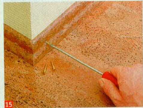
Ist der Akkuschrauber zu klobig, muss der Schraubendreher heranziehen. Vorteil bei der Verschraubung: Die Leisten lassen sich später problemlos entfernen
