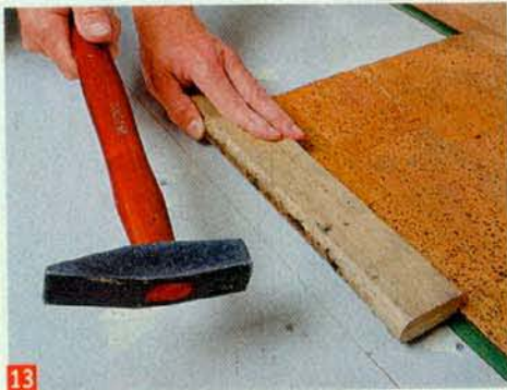
Meistens muss man bei diesem Korkfertigparkett den Schlagklotz zur Hilfe nehmen, damit die Elemente bündig ineinander einrasten
